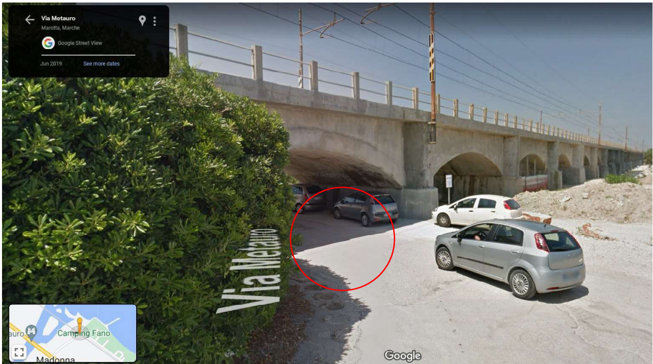
Figura 18. Sottopasso Ferrovia (Via Metauro)
