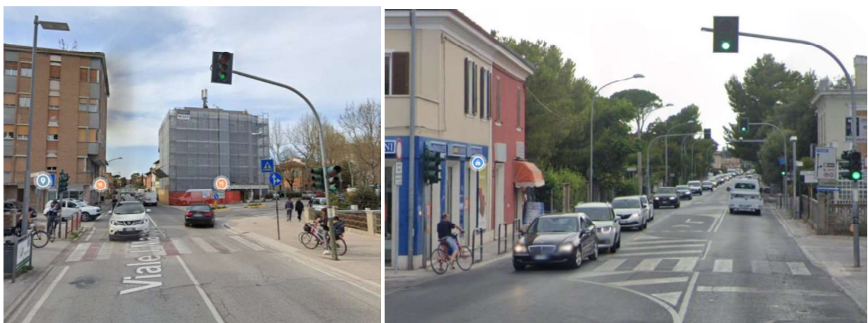
Figura 36. Impianti semaforici in Viale I Maggio
