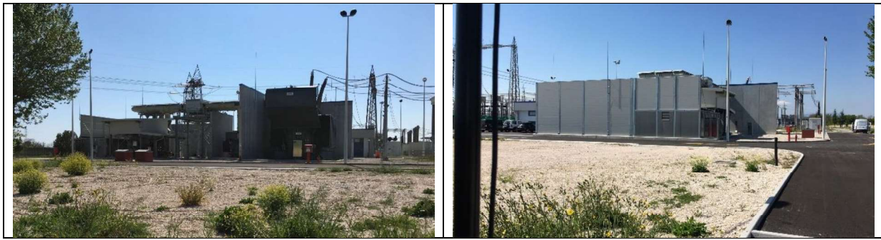
Figura 1 – S.E. di Fano – Immagini fotografiche del nuovo impianto ICS.
