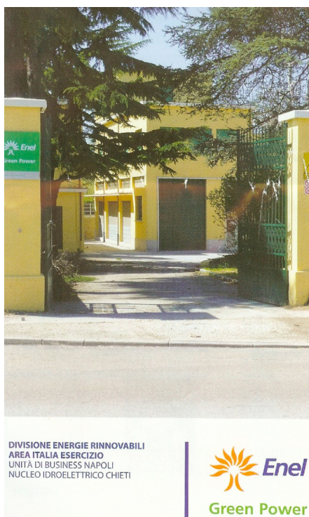
Fig.2.29_Centrale della Liscia
